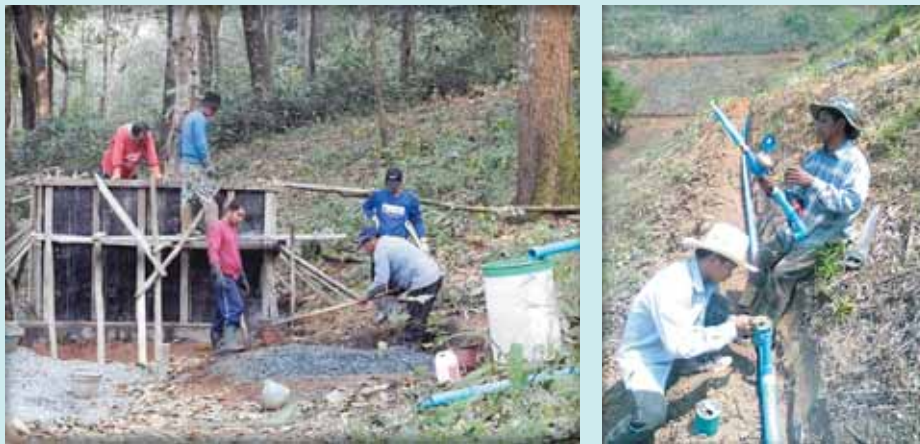
1.4 ซ่อมแซมระบบส่งน้ำชลประทาน จำนวน 5 กิโลเมตร
